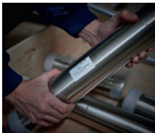
↑ Eenvoudige montage door doorlopende en duidelijke etikettering van de op lengte gesneden buisleidingen.
